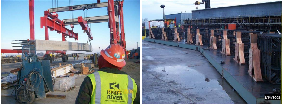
Fig. 4 – Arch Rib Production
