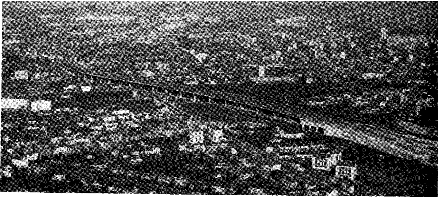
Fig. 1.18. B.3. Viaducts (Paris).
