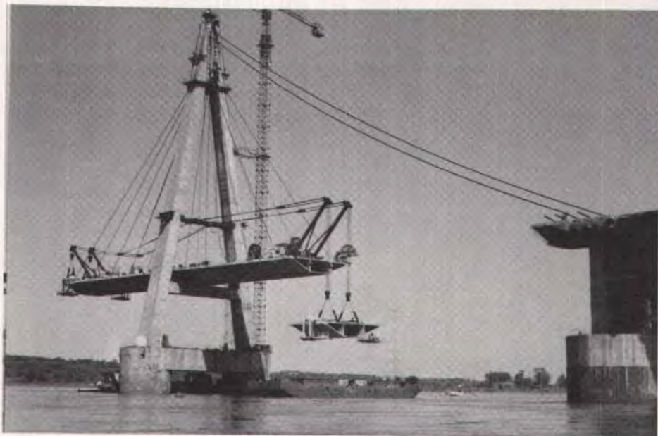
Fig. 43. Erection of Posadas Encarnación Bridge, Argentina.
